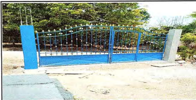
Foto 2: Colocación del porton
