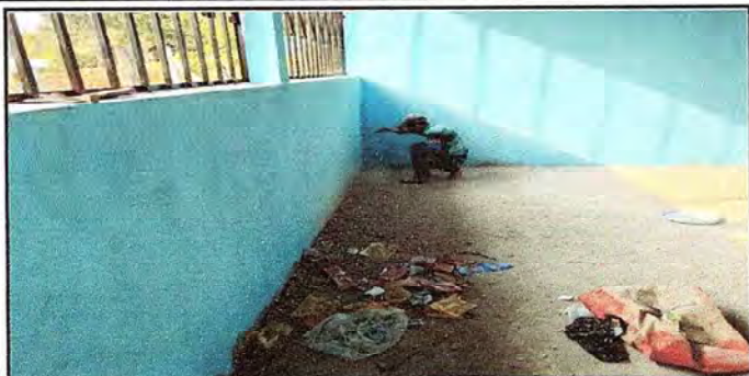
Foto 1: División de Aulas
