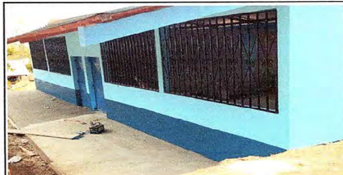
Foto 4: Colocación de balcones
