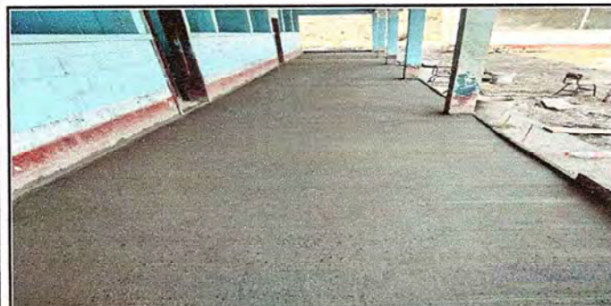
Foto 3: Colocación de piso
